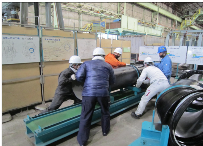
管接合研修 (16日) 状況
