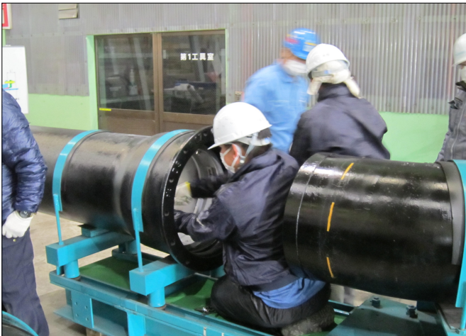
管接合研修 (16日) 状況
