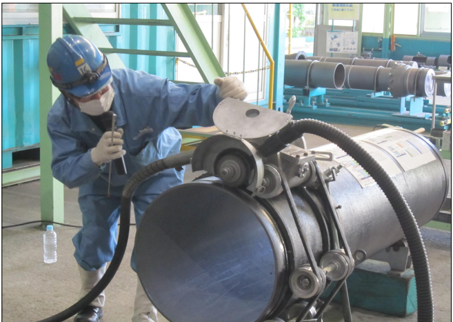
管接合研修 (15日) 状況
