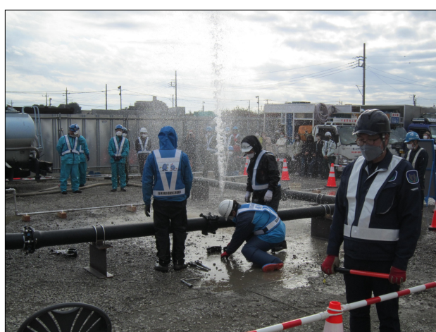
(株)エイキ 特殊継手の応急工法訓練
