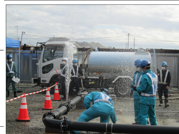
(株)杉本建設 特殊継手の応急工法訓練
