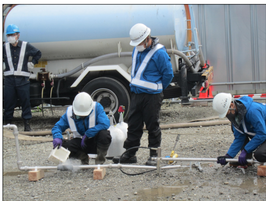
栄進工業(株) 凍結工法実技訓練
