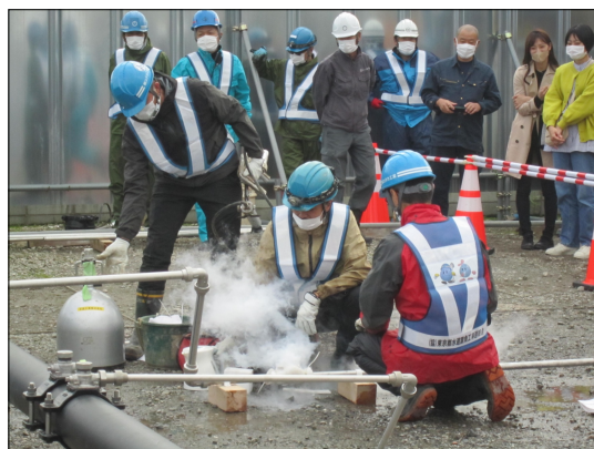
(株)ユタカ工業 凍結工法実技訓練
