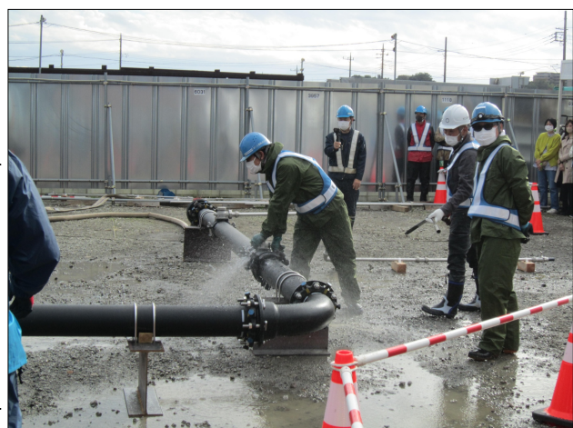
不二工業(株) 特殊継手の応急工法訓練
