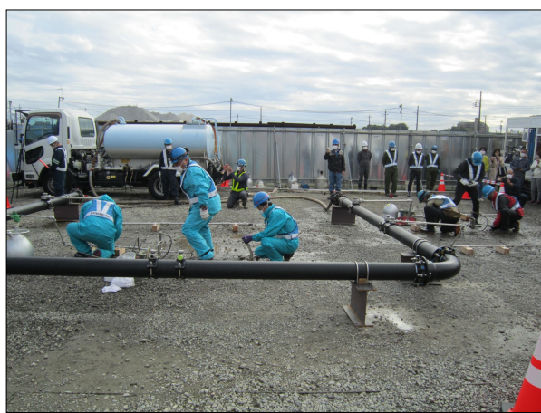
第1班(2社)凍結工法実技訓練状況
