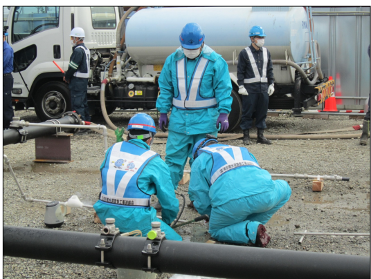
(株)杉本建設 凍結工法実技訓練
