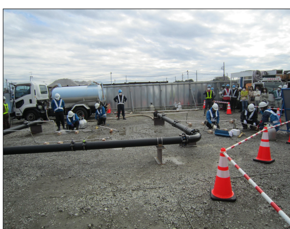
第2班(2社)凍結工法実技訓練状況
