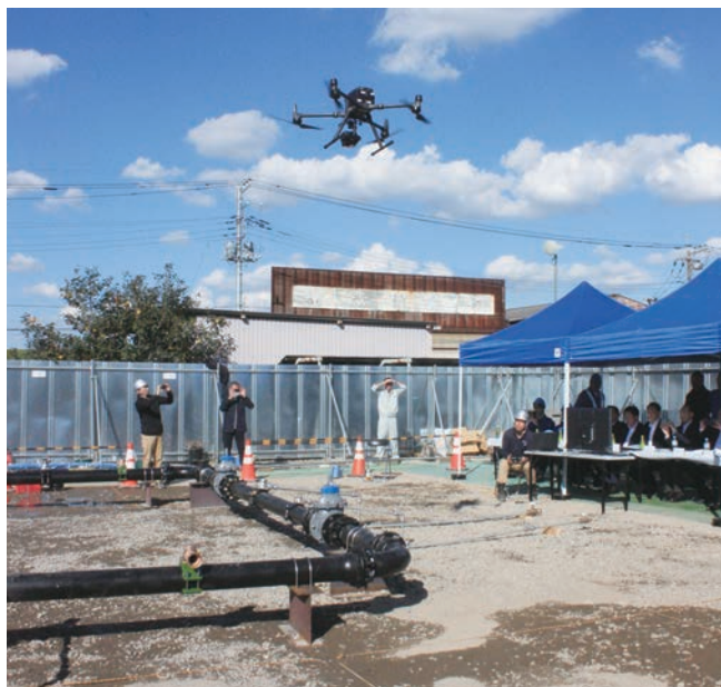
仮設配管の上を飛ぶドローン
