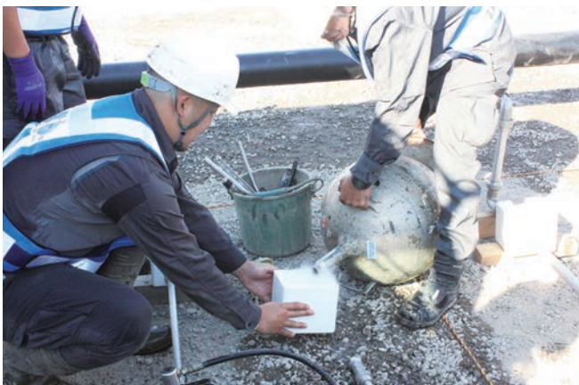
凍結方法により止水する
