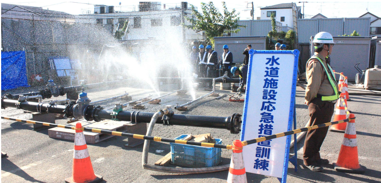
実際に看板を設置して訓練
