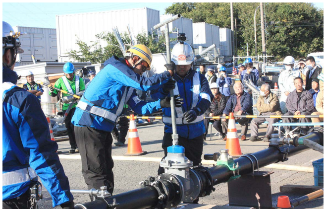
破損した管路の復旧
