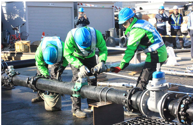
仮設配管を接続
